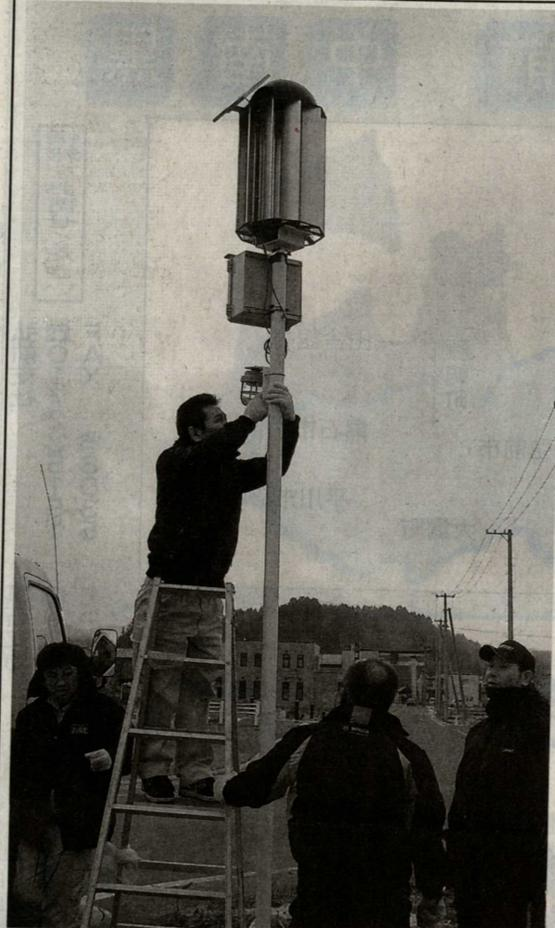
野田村の電力未復旧地域に風力と太陽光で発電するLEDライトの街灯を試験設置する関係者=18日
